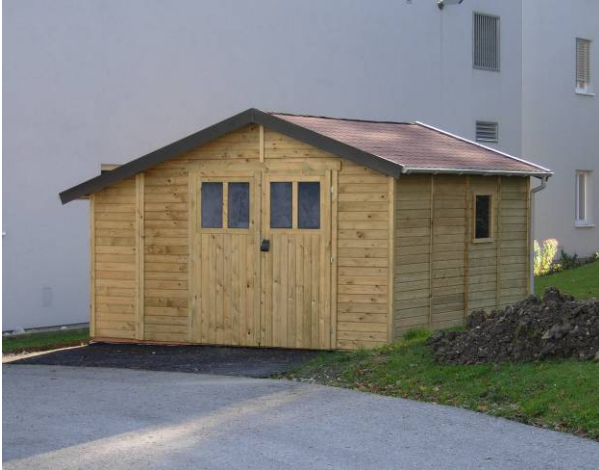
Errichten einer Gerätehütte
