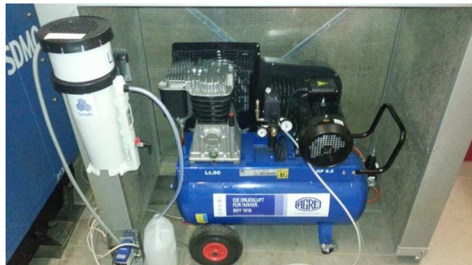
Neuer Kompressor und Schallschutzhaube
