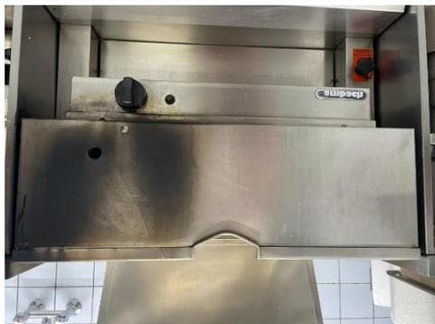
Alarmierung um 9:15 Uhr durch Florian LFK. Vermutlich durch einen technischen Defekt ist es zu einem Brand an einen mit Gas betriebenen Küchengerät gekommen. Durch das umsichtige Handeln und das beherzte Eingreifen der Mitarbeiter, die sofort die Gasversorgung abgedreht haben, konnte Schlimmeres verhindert werden. Durch die Feuerwehr wurde die Brandstelle mittels der Wärmebildkamera nachkontrolliert. Einsatzdauer: 30 Minuten, 17 Mann im Einsatz.
